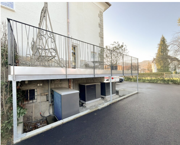
Verdeckte Installation: Die drei Wärmepumpen befinden sich unter der Terrasse und fügen sich damit vollständig in den denkmalgeschützten Bestand ein.
