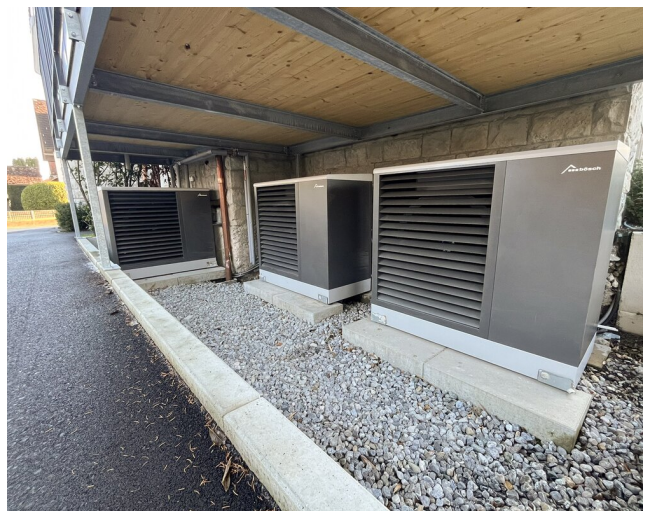
Verdeckte Installation: Die drei Wärmepumpen befinden sich unter der Terrasse und fügen sich damit vollständig in den denkmalgeschützten Bestand ein.
